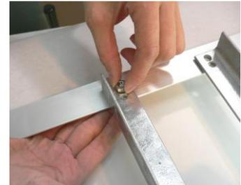
3. ボルトに付属のワッシャーを通しナットを嵌め、ゆるく締めます。
