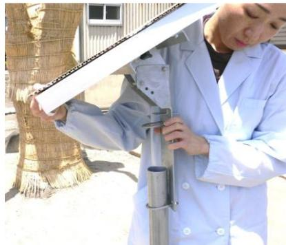
8. 金具の2箇所のU字ボルトへ「単管パイプ」を差込みます。
