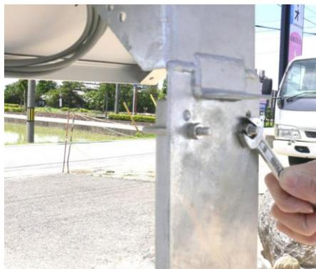
10. 2本のU字ボルトの4箇所のナットをしっかりと締め付けま
