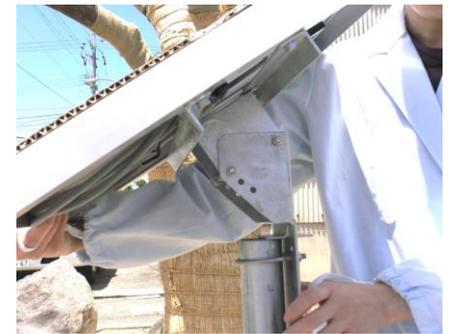
9. 単管パイプの先端が金具のストップへ当たるまで差し込みます。
